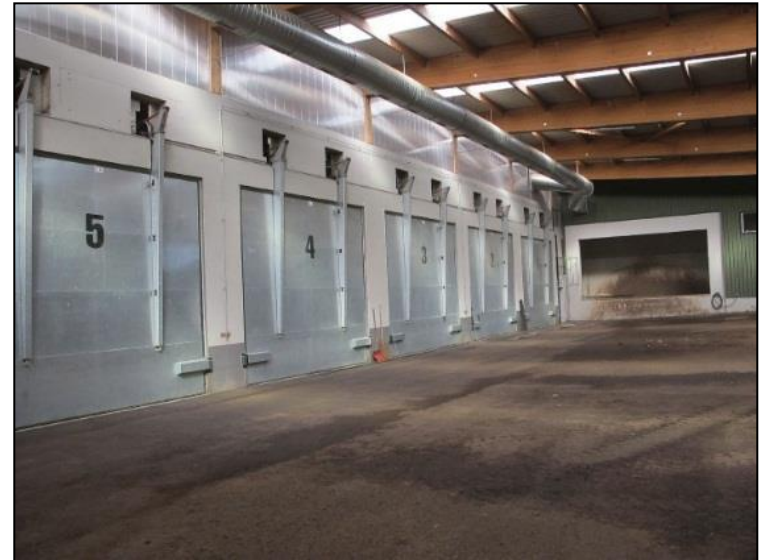
Biogasanlage im Kt. Zug (Quelle : BAFU 2016)
