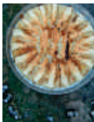
Die erste Schicht des Flija-Turms ist fertig.
